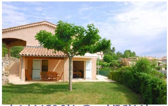
« LA MAISON Du VIGNAL »
